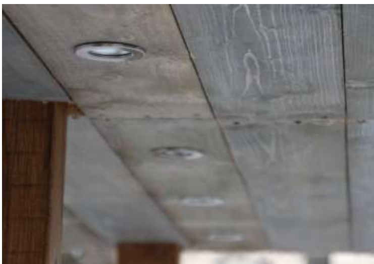
Svetlá sa cez deň rozsvetujú tlačidlom, v noci sa aktivujú fotobunkou automaticky.
